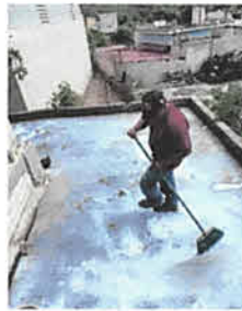
Foto 3: Durante la Impermeablización de loza de la cocina por humedad y filtración de agua.
