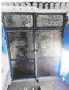
Foto 5: Durantes la Reparación de portón de ingreso (lijado, pintura y bisagras) medida de 2.5'2mts.
