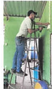
Foto 4: Durante la Sustitución del sistema eléctrico en las aulas.
