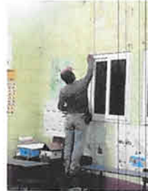
Foto 2: Durante la colocación de ventana PVC de la parte trasera de 4 aulas
